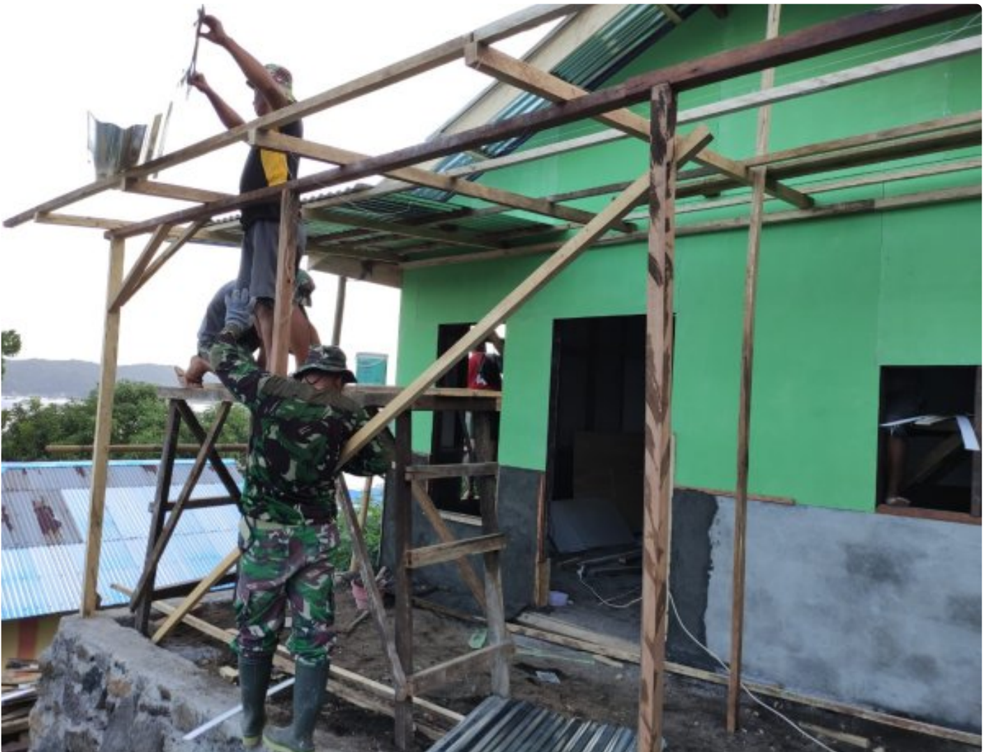
Pekerjaan RTLH Keluarga Galvin Karaki Oleh Satgas TMMMD Ke-116 Kodim 1310 di Kelurahan Tandurusa
